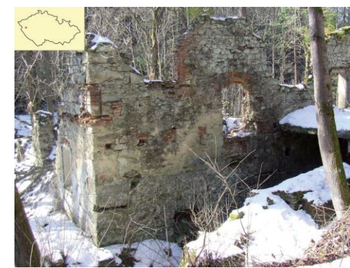
10) Bloumský mlýn na Hamrském potoce (okres Tachov). Příklad zaniklého objektu v západoběšském pohraničí. Pohled od severu (foto: L. Galusová 2011). Pomer der Mühle am Hamrabach (Kreis Tachau). Beispiel eines untergegangenen Objekts im westböhmischem Grenzgebiet. Blick von Norden (Foto: L. Galusová 2011).
