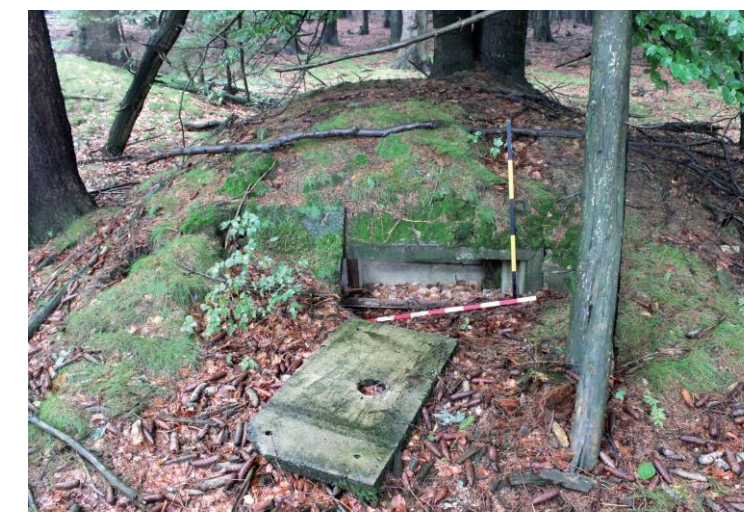
Palebný objekt z železobetonových prefabrikátů KŽ-1 pro těžký kulomet. Schützobjekt aus Eisenbetonpräfabrikaten KŽ-1 für das schwere Maschinengewehr.
