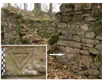
3) Mlýnský náhon (okres Tachov). Pohled do mílnice od jižního západu. Kamenná zadje návodní zdi, za níž se odlečob vodní kolo (zde se nalézala lechice), přičemž otvorem procházela hřídele dovnitř místnosti a rozčlečba pomocí palečného kola následně celý mléč mechanismus. VM Mlýnský náhon zůstal dochován archaický mléč mechanismus. V mílnici, kde pracoval mléč stroj, se našlo částečně povrchu terénu dochová litinový čep průměru 3,5 až 4 cm, osazená kovovou řemenicí (na fotografii přibližně uprostřed). Patně součástí náhonu doplněného zařízení využíval jeho vodní energii. Sada součástí stroje na výrobu perletových knoflíků (foto: J. Andeale 2007). Mäsa-Mühle (Kreis Tachau). Blick in das Mühlenhaus von Südwest. Die Steinmauer ist eine Zuleitungsmauer, hinter der sich das Mühlrad drehte (hier befand sich auch die Kühlkammer), wobei die Welle durch die Öffnung in den Raum ragte und anschließend mittels des Daumenrads den ganzen Mehlmehanismus in Gang setzte. In der Mäsa-Mühle blieb ein archaischer Mehlmehanismus erhalten. Im Mühlenhaus, in der die Mähmaschine arbeitete, blieb auf dem gegenüberliegenden Gebäude eine mit einer Metallriemenscheibe besetzte Gussstange mit einem Durchmesser von 3,5 bis 4 cm erhalten (auf dem Foto ca. in der Mitte). Diese war wahrscheinlich ein Bestandteil einer zusätzlichen, Wasserkraft nutzenden Anlage. Vielleicht Bestandteil einer Maschine für die Fertigung von Perlmutterknöpfen. (Foto: J. Andeale 2007).
