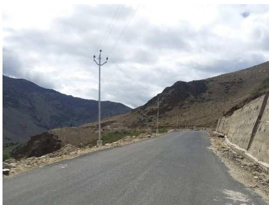
Obr. 1: Úsek zanskarské dálnice blízko dokončení (foto: autor 2022)
